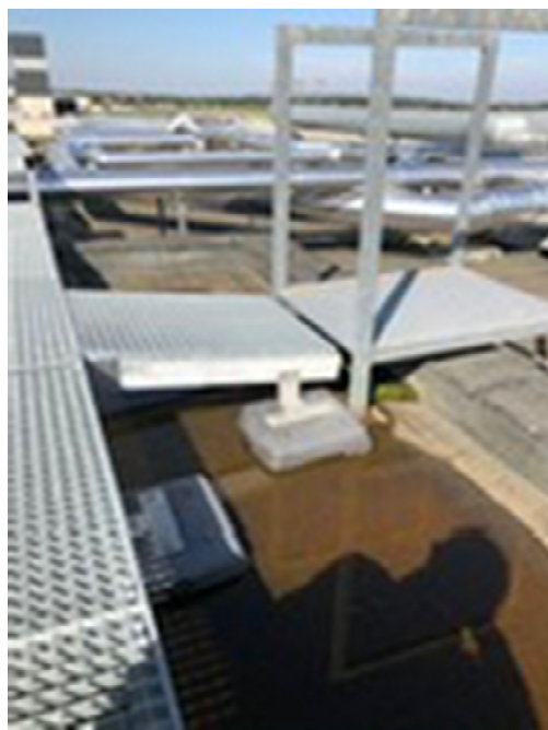
platelage avec plots de répartition sur eau stagnante
