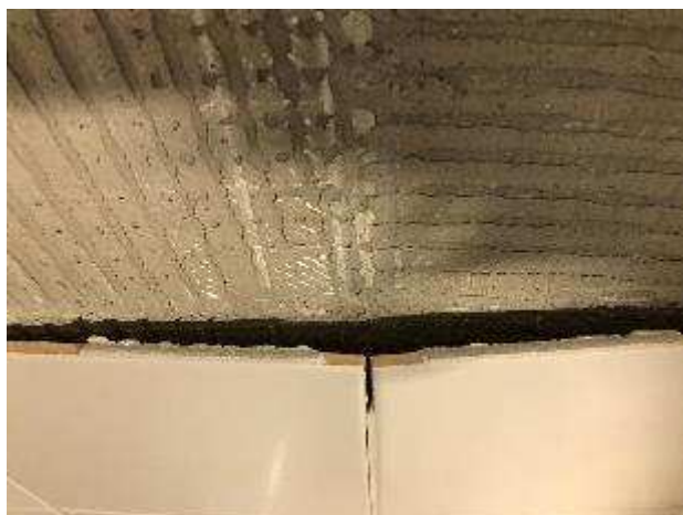
mise en compression des carreaux sur cloisons
