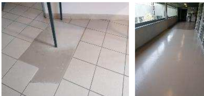
Décollement du carrelage et remplacement de sol anciennement carrelé
