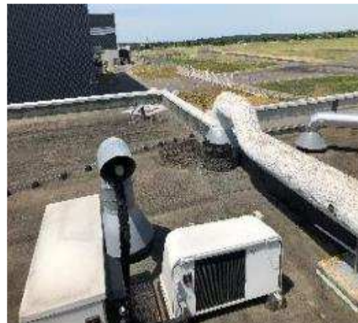
Flashe à l'angle étanchéité usée
