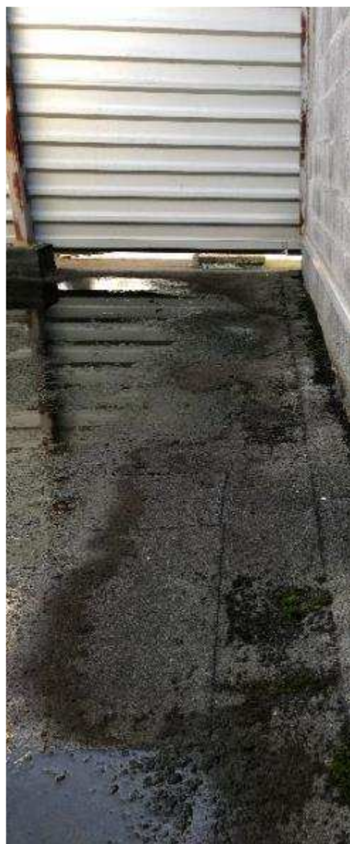
flache dans local CTA (condensats)
