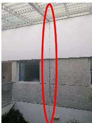
Repérage des joints de dilatation du bâtiment
