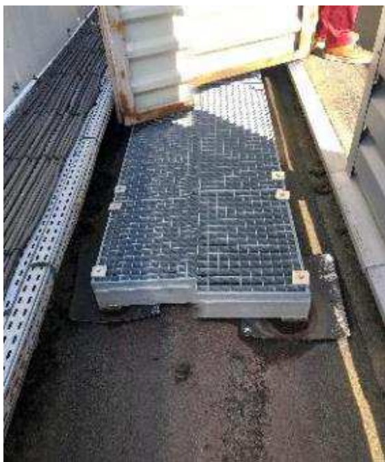
Platelage avec plots poinçonnant
