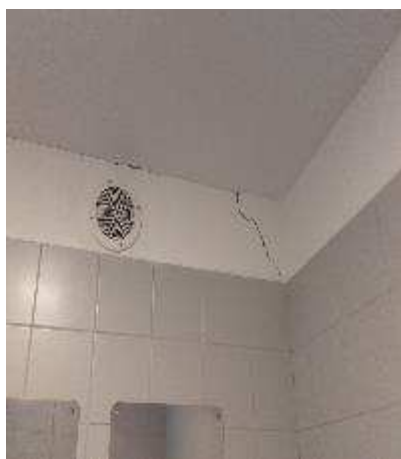
fissures sur cloisons maçonnées
