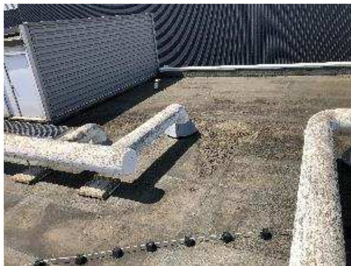
Etanchéité dégradée devant gaine de soufflage
