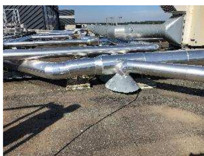
Etanchéité dégradée devant gaine de soufflage
