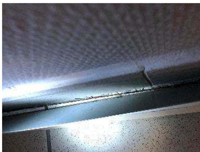
Absence de remontée de résilient derrière les plinthes
