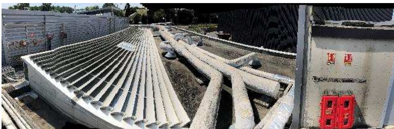
Verrière fuyarde en périphérie et au droit des joints de vitrage
