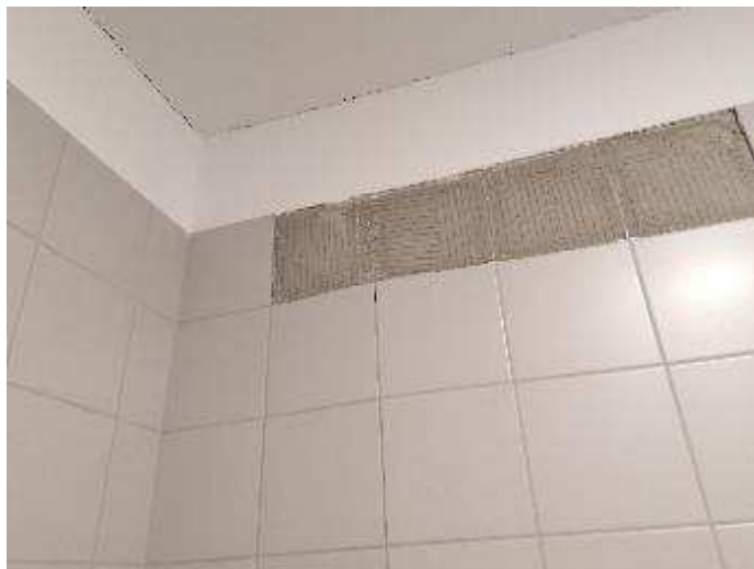
Fissuration le long des cloisons et décollement du carrelage
