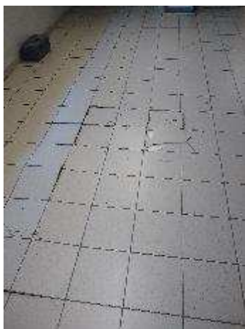
mise en compression des carreaux
