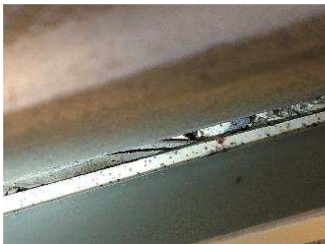
Absence de résilient entre mur et carrelage
