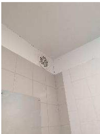
Fissuration le long des cloisons et décollement du carrelage
