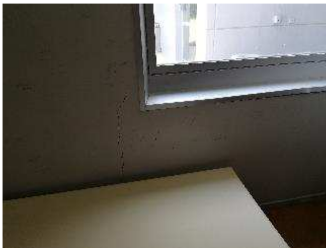
Fissuration au niveau d'un appui de fenêtre d'une chambre du secteur B
